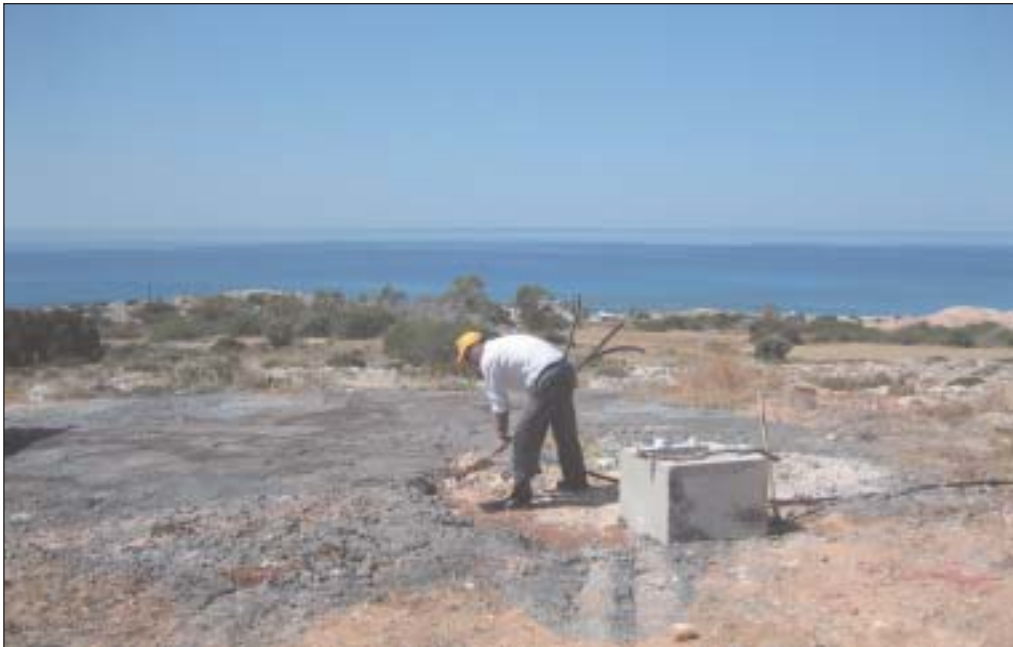
Εικ. 5. Εγκατάσταση γεωθερμικού εναλλάκτη στη γεώτρηση της Αγίας Νάπας. Fig. 5. Installation of geothermal exchangers in the Agia Napa borehole.
