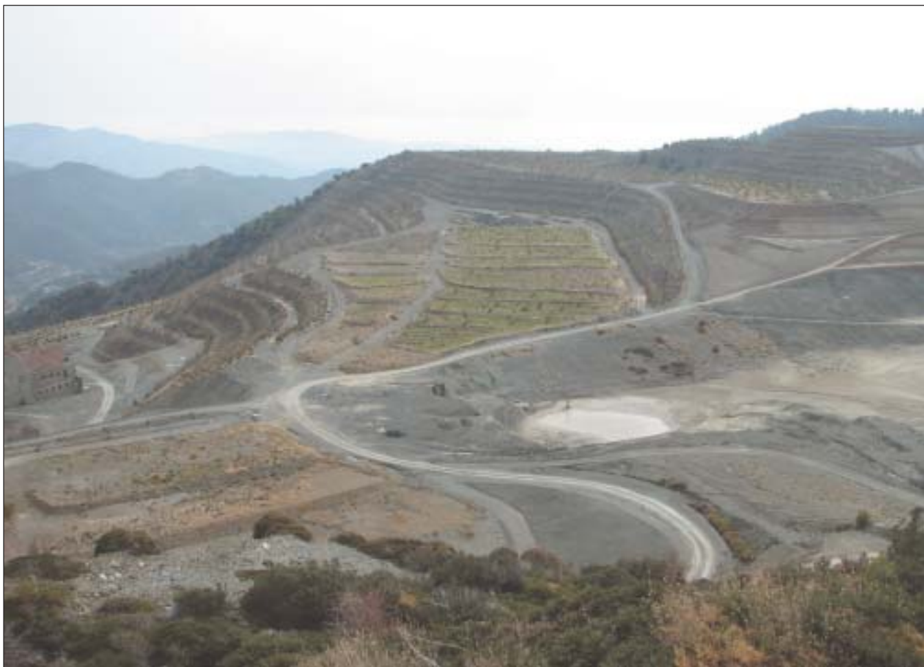
Εικ. 7. Πανοραμική φωτογραφία του Μεταλλείου Αμιάντου όπου φαίνονται οι εργασίες αποκατάστασης.
