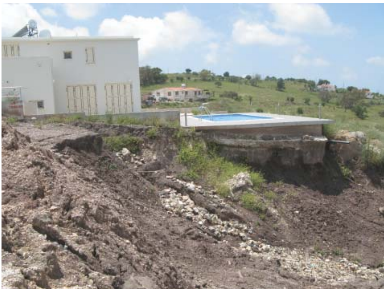
Εικ. 21. Επίδραση κατολισθήσεων στο δομημένο περιβάλλον. Fig. 21. Landslide effects to the built environment.
