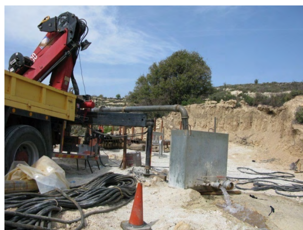
Ανόρυξη υδρογεώτρησης με σφυρογεωτρήπανο (αριστερά) - Drilling of a borehole with a Schramm rig (left) Δοκιμαστική άντληση σε γεώτρηση στην περιοχή Τροόδους (δεξιά) Pumping test in a borehole in the Troodos area (right)
