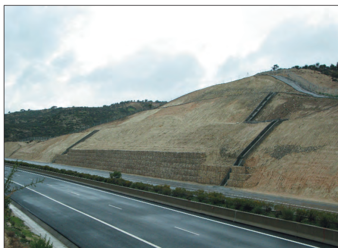
Εικ. 12: Η κατολίσθηση, οι εργασίες αποκατάστασης και το τελικό αποτέλεσμα στον αυτοκινητόδρομο Πάφου – Λεμεσού, κοντά στο Πισσούρι.
