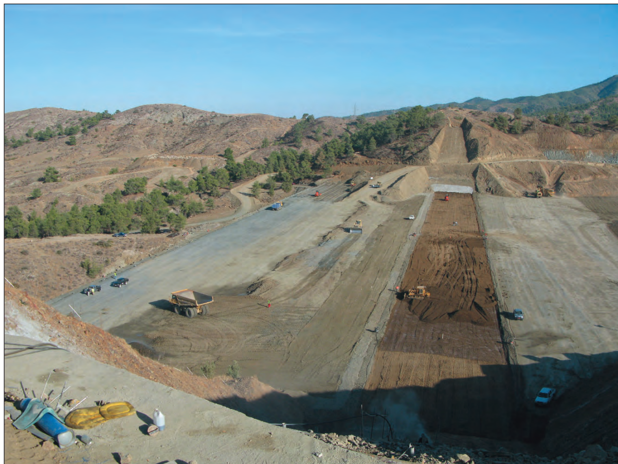
Εικ. 10: Διάστρωση αργιλικού πυρήνα και φίλτρων στον άξονα του Φράγματος Σολήας.
