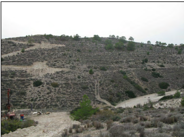
Πανοραμική Αποψη προς τα δυτικά, της Θέσης και της Λίμνης του υπό μελέτη Φράγματος Τερσεφάνου. Ανόρυξη διερευνητικής δειγματοληπτικής γεώτρησης στην θέση του άξονα.
