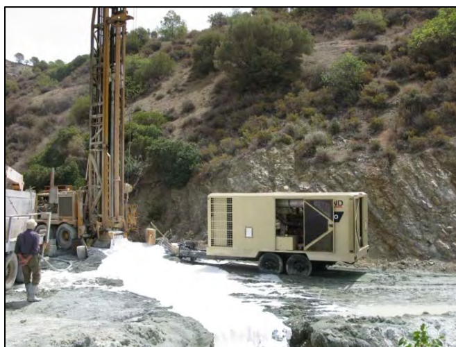
Ανόρυξη υδρογεώτρησης με σφυρογεωτρήπανο Drilling of a borehole with a Schramm rig
