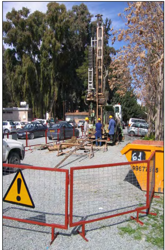
Εργασίες ανόρυξης ερευνητικής γεώτρησης με το δειγματοληπτικό γεωτρώπανο του Τ.Γ.Ε. στα πλαίσια της γεωτεχνικής μελέτης για την κατασκευή των κτιριακών εγκαταστάσεων του Πολιτιστικού Κέντρου Κύπρου στη Λευκωσία. Drilling works of exploratory borehole undertaken by the sampling Rig of G.S.D. within the framework of geotechnical investigation for the construction of the Cultural Centre in Nicosia
