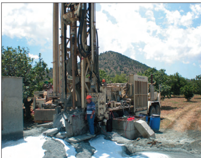
Εικ. 9: Ανόρυξη παραγωγικής γεώτρησης – Δοκιμαστική άντληση σε γεώτρηση. Fig. 9: Drilling a water supply production borehole – Performing pumping test on a borehole.
