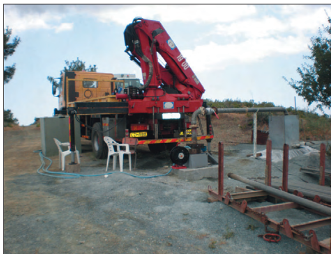
Εικ. 9: Ανόρυξη παραγωγικής γεώτρησης – Δοκιμαστική άντληση σε γεώτρηση. Fig. 9: Drilling a water supply production borehole – Performing pumping test on a borehole.
